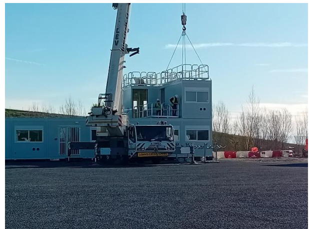
Installation des modules de bureaux
