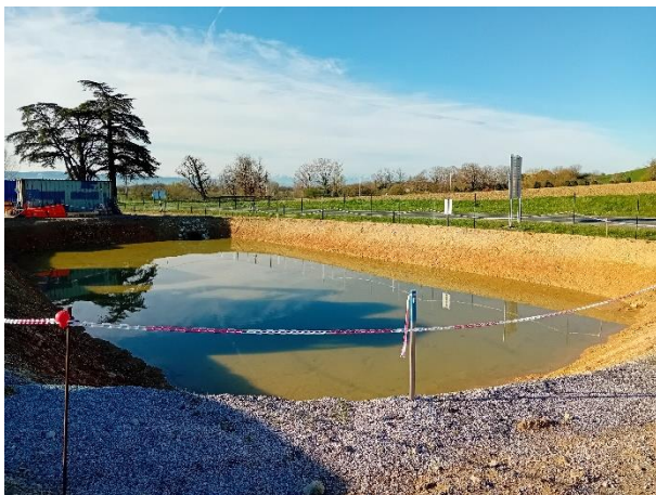
Bassin de traitement des eaux de la base vie
