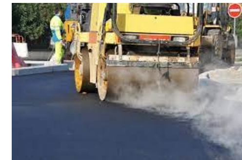
Enrobés à chaud Mélange chargé dans les camions entre 160° et 180°
